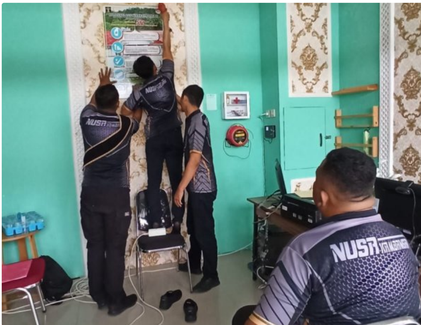
Kabapas dan Staff Renovasi Ruang Baladewa
